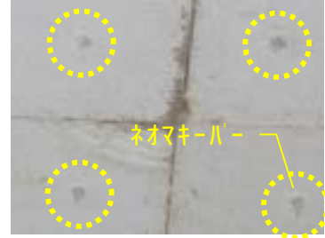
型枠脱型後
