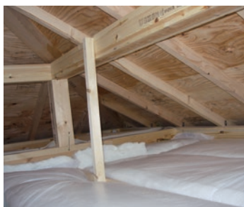
天井点検口などから入って施工
