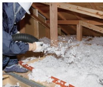
天井点検口などから入って施工
