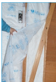
グラスウールを筋交いの後ろに充填します。
