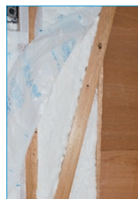
筋交いに沿ってグラスウールに切り込みを入れ、グラスウールを筋交いと同面に盛り上げます。
