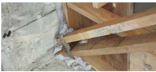
ノロ止め(コンクリート型枠の隙間にインサルシールを充てん)
