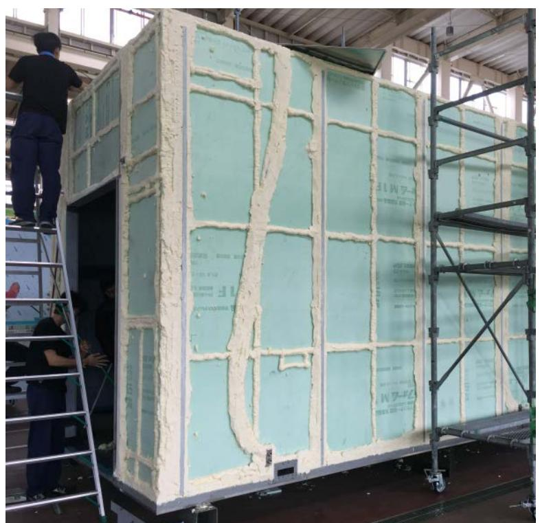
業務用冷蔵庫(冷蔵庫周りの断熱材の隙間充てん)
